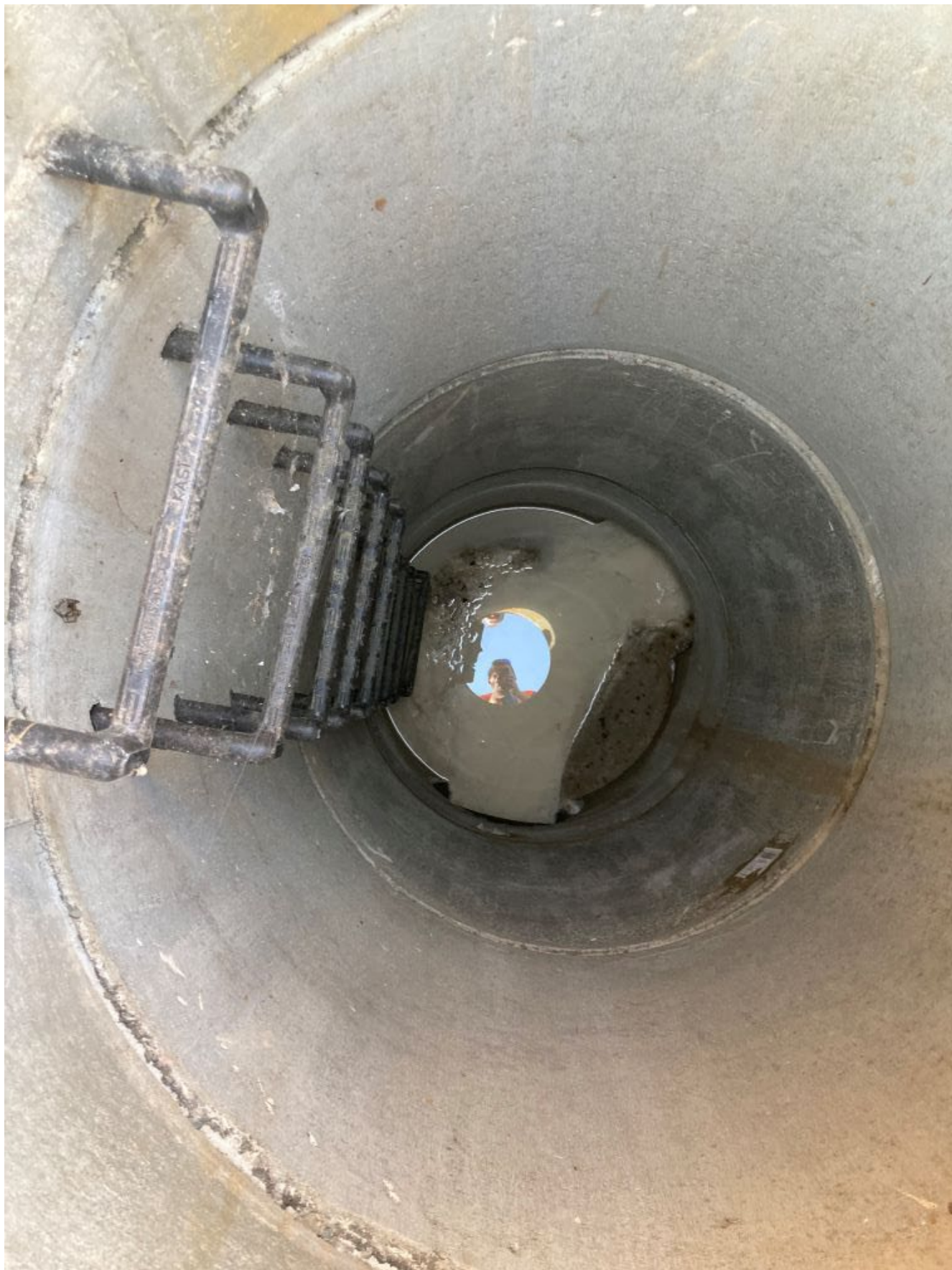
Šachta výtoku drenáže v podloží vlevo v km 179,922
