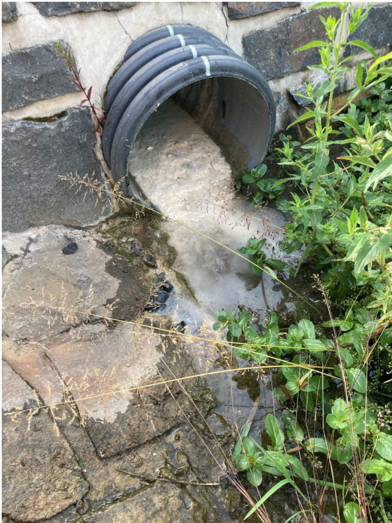
Výtok z podložních drenáží – vyústění do výtoku z propustku v km 179,925 vlevo
