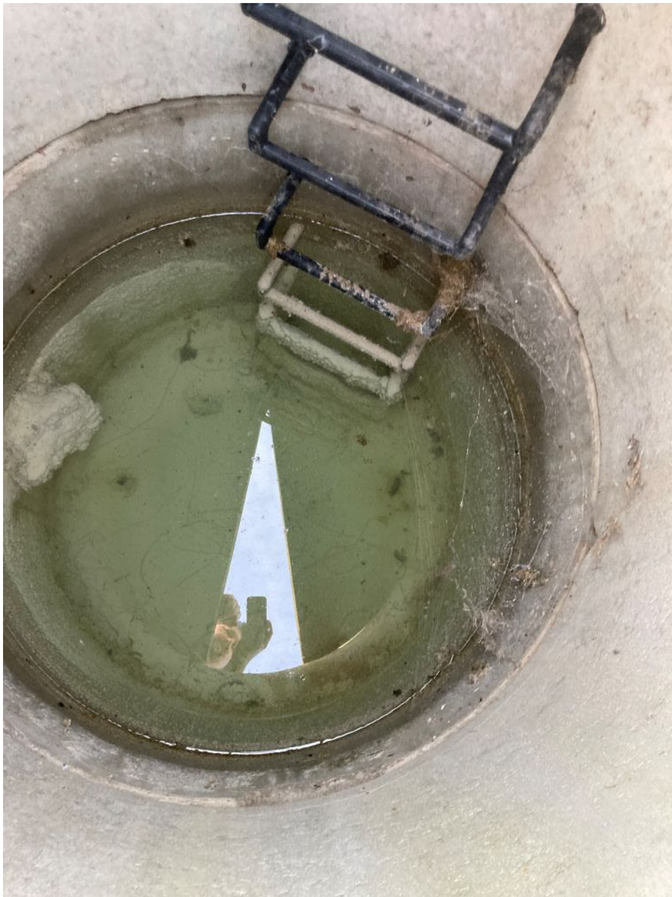
Přepadová jímka z drenáže podloží v km 179,935 vyvedená do vtoku meliorací v km 179,925 vlevo
